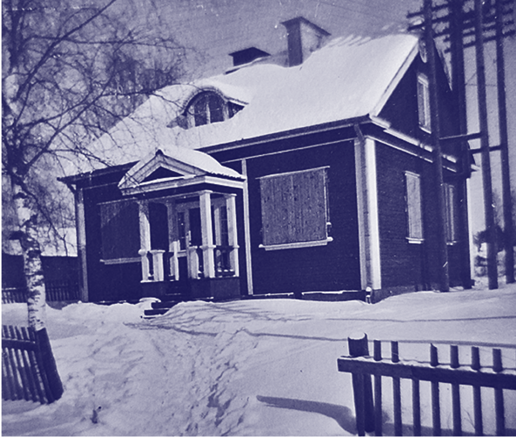
Vilppulan puhelinkeskus. Ikkunat on pimennetty.
